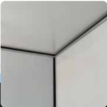
Terminación interior de paneles Big Skin y techo
